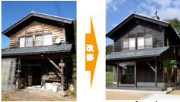
改修前(空き家) 改修後(グループホーム、飲食店、宿泊施設等)
